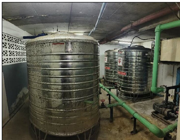
สภาพบริเวณห้องปั้มน้ำ พื้นที่ชั้นใต้ดิน
