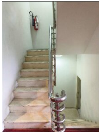
สภาพบันไดหนีไฟ, บันไดขึ้น-ลงระหว่างชั้น และระบบป้องกันอัคคีภัยภายในอาคาร
