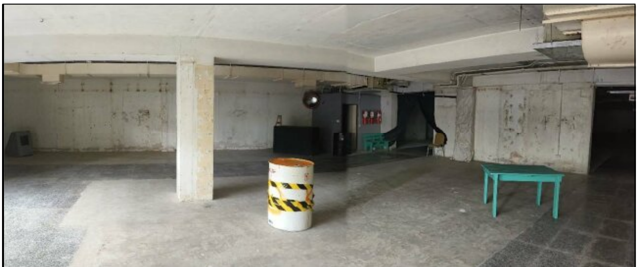
สภาพภายในอาคาร บริเวณชั้นใต้ดิน
