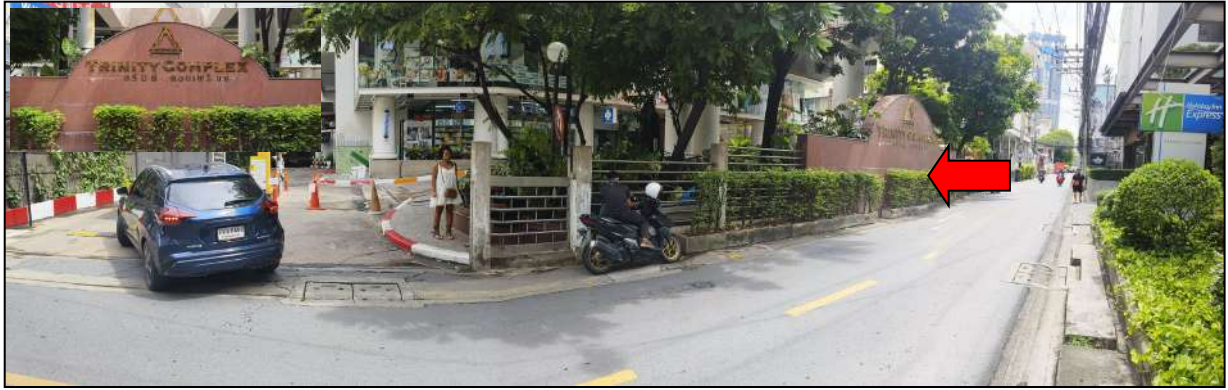
จุดถ่ายภาพที่ 4 : สภาพด้านหน้าอาคารชุดตริไนดี คอมเพล็กซ์ อาคารที่ตั้งทรัพย์สิน
