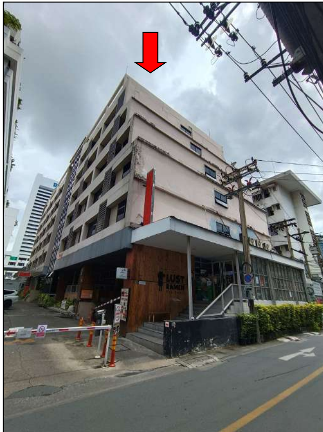
จุดถ่ายภาพที่ 5 : สภาพบริเวณด้านหน้าอาคารที่ตั้งทรัพย์สิน โรงแรมตริณีดี สีสลม
