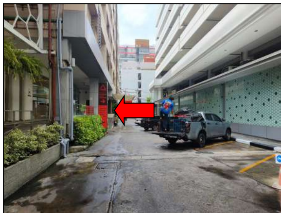
จุดถ่ายภาพที่ 7 : สภาพถนนภายในโครงการทรินิตี้ คอมเพล็กซ์ ผ่านหน้าอาคารที่ตั้งทรัพย์สิน
