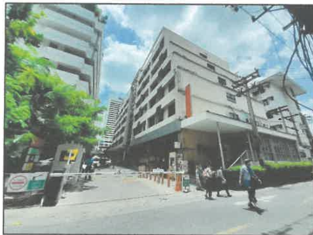
สภาพด้านหน้าอาคารชุดตรีนิติ คอมเพล็กซ์ อาคารที่ตั้งทรัพย์สินที่ประเมินมูลค่า (จุดถ่ายภาพที่ 4)
