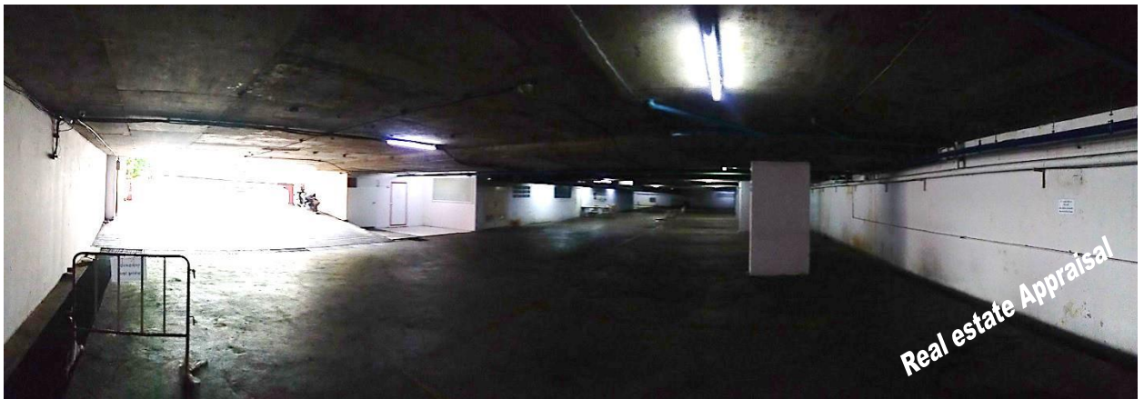
สภาพภายในอาคารชั้นที่ใต้ดิน / ที่จอดรถ
