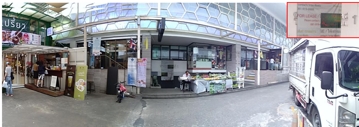
สภาพอาคารชุดตริณีดี คอมเพล็กซ์ เลขที่ 425/128 ชั้นใต้ดิน และเลขที่ 425/129 ชั้นที่ 1 / ร้านค้า (พื้นที่พาณิชย์กรรม)
