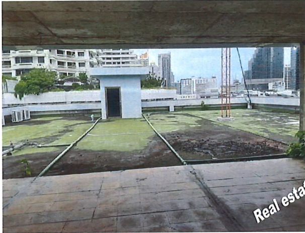
สภาพชั้นดาดฟ้า
