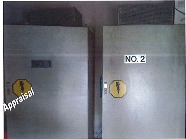
สภาพชั้นดาดฟ้า / ห้องเครื่องลิฟต์โดยสาร
