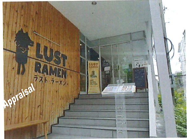
สภาพภายในอาคารชั้นที่ 1 / ร้านอาหาร
