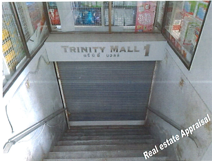
สภาพห้องชุดชั้นใต้ดิน / ร้านค้า (พื้นที่พาณิชย์กรรม) ปัจจุบันยังไม่เปิดให้บริการ
