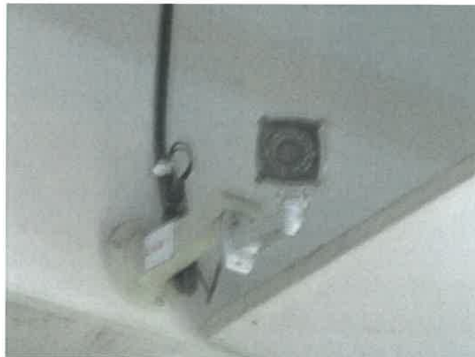
สภาพทรัพย์สินส่วนที่ 2 อาคารชุดตริไนต์ คอมเพล็กซ์ (พื้นที่พาณิชย์กรรม) ชั้นที่ 1 (ส่วนงานระบบความปลอดภัย)
