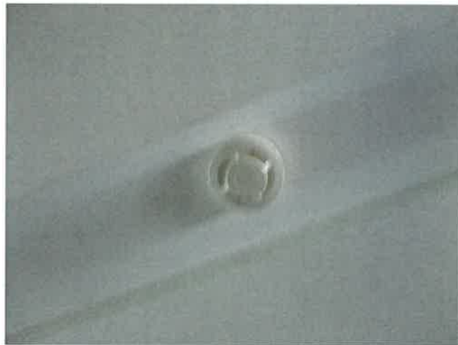
สภาพทรัพย์สินส่วนที่ 1 อาคารตริทิพย์ 2 (อาคาร สตูดิโอ) เซอร์วิส อพาร์ทเมนท์ ชั้นที่ 6 (ส่วนงานระบบความปลอดภัย)
