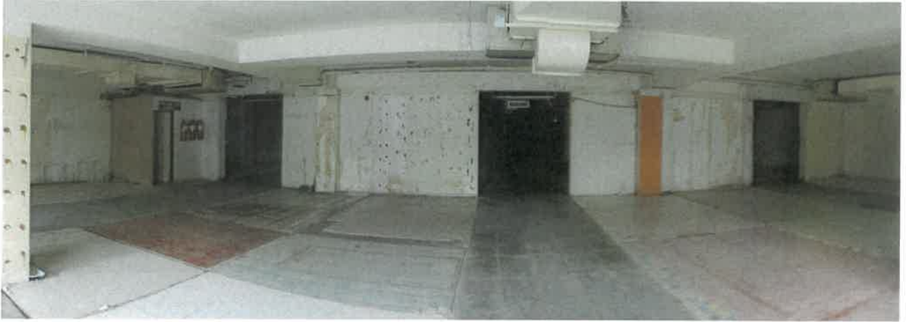
สภาพภายในทรัพย์สินส่วนที่ 1 อาคารตรีทิพย์ 2 (พื้นที่พาณิชย์กรรม) ชั้นล่าง (ร้านค้า)
