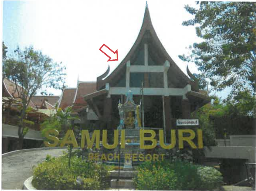
สภาพอาคารต้อนรับ 2 ชั้น (Lobby & Reception)
