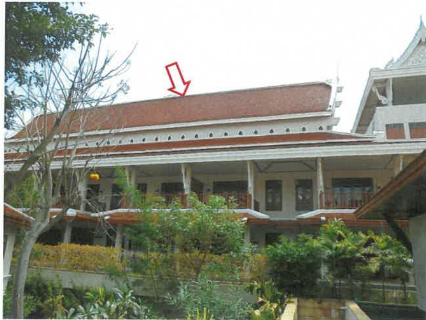
สภาพอาคารโรงแรม 4 ชั้น (อาคาร B)
