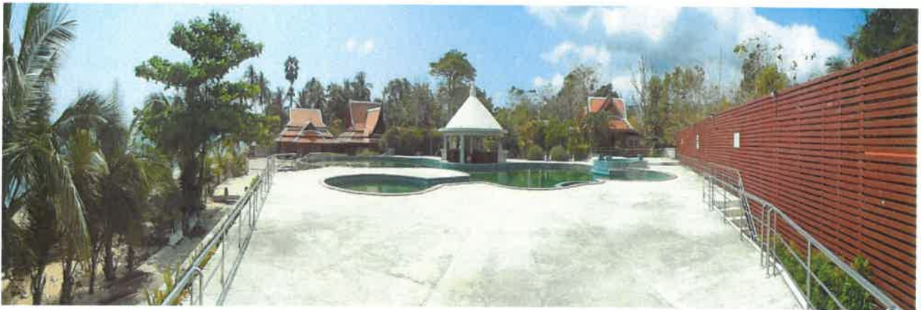
สภาพสระว่ายน้ำ และทางเดินรอบสระ พร้อมห้องออกกำลังกาย และห้องเด็กเล่น
