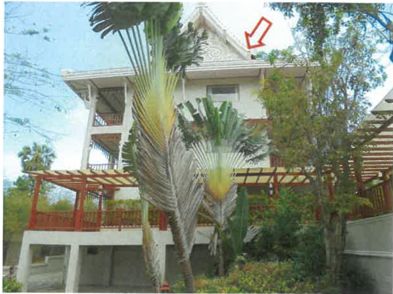
สภาพอาคารโรงแรม 4 ชั้น (อาคาร A)
