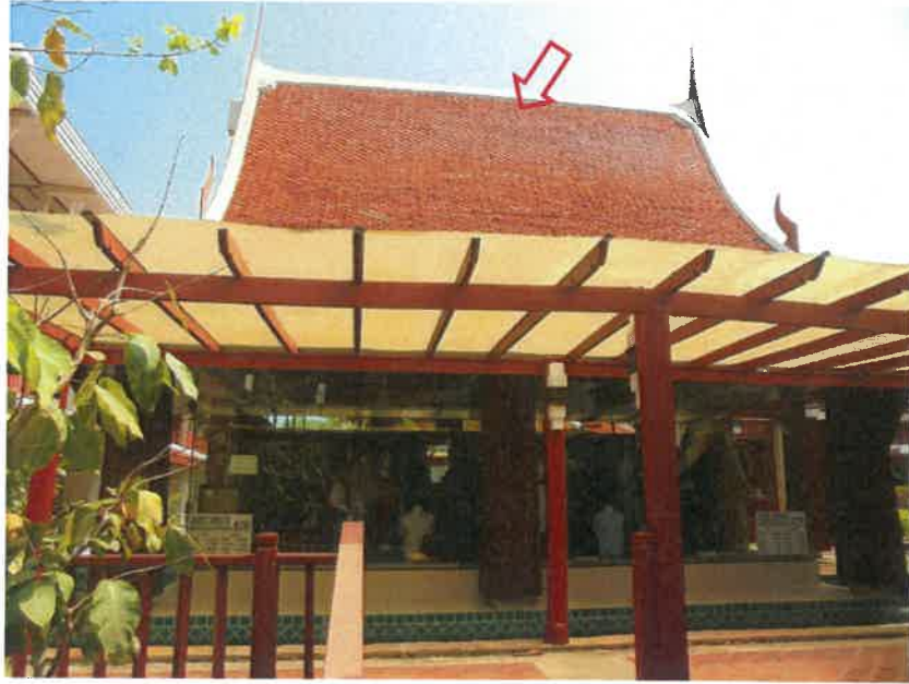
สภาพอาคารแกลลอรี่ 2 ชั้น
