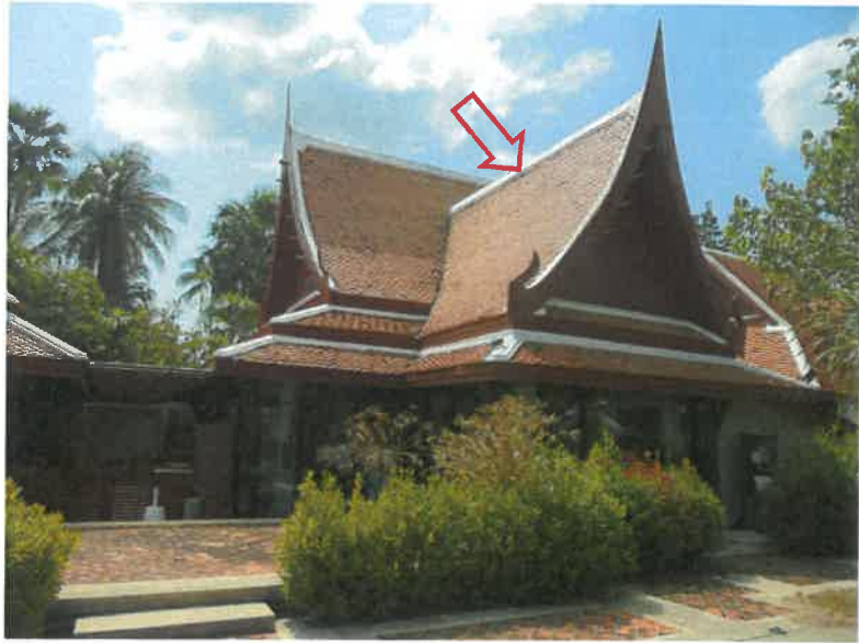
สภาพอาคารห้องครัว
